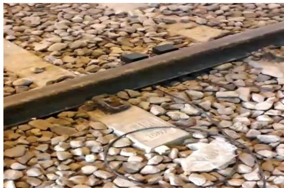
**Gambar 2.** instalasi sensor *proximity* sebagai *input*
