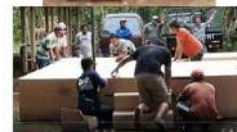
Pemasangan panggung portable
