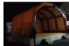
Gambar 12. Pemasangan Prototip Atap Panggung Tiup (6 menit)
