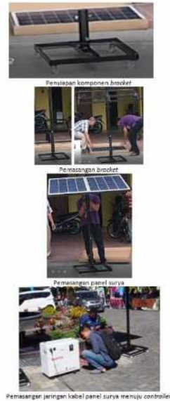
Gambar 13. Pemasangan Portable Bracket dan Panel Solar Energi Fotovoltaik (20 menit)
