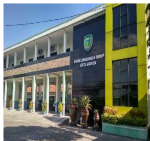
Gambar 7. Gedung Lingkungan Hidup Kota Madiun.
