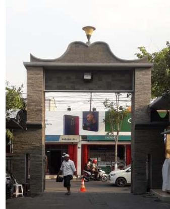
Gambar 20. Gerbang sisi utara, yang mengadopsi gerbang utama yang dibongkar. i. Menara
