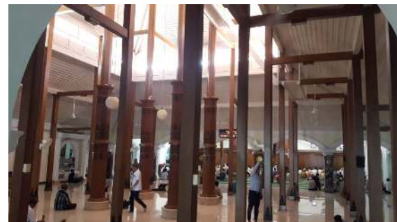
Gambar 7. Struktur Soko Guru sebagai penopang atap piramida bertumpuk pada Masjid Agung Lamongan
