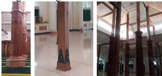
Gambar 23. Ornamen pada kolom utama (kiri), pendukung (tengah), dan terdapat tangga ke atap (kanan).
